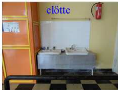
Vizes blokk felújítása
