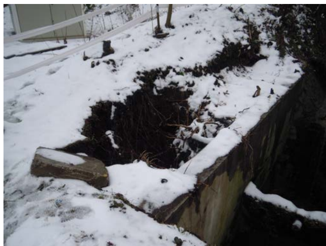
Kimosódott talaj a műtárgy mellett
