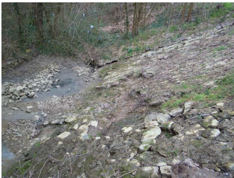
Tönkrement árapasztó műtárgy
