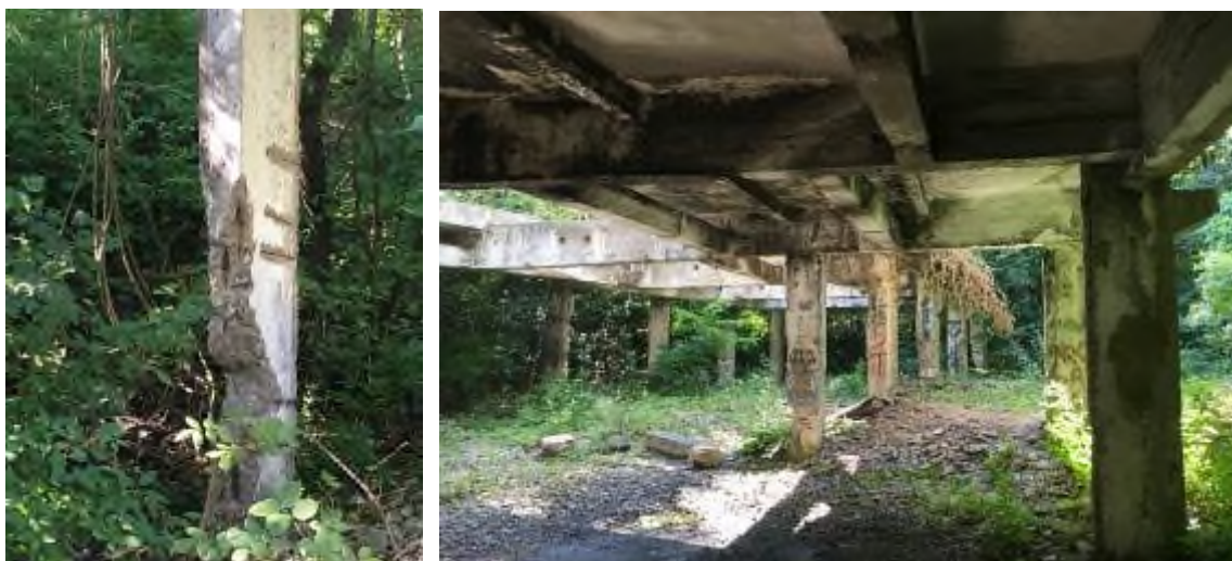
2. ábra: Életveszély: megrongált és elgyengített tartószerkezet, elkorrodált betonacél
