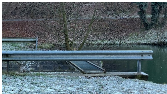
A meglévő „híd”
