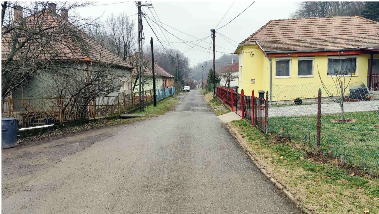
Az Engel Adolf utca felújítandó szakasza (marás/aszfaltozás).
